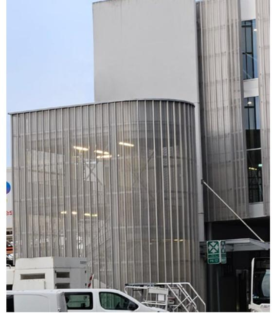
Esta solución permite la aplicación directa sobre estructuras de acero, madera u hormigón, eliminando la necesidad de una estructura secundaria.
